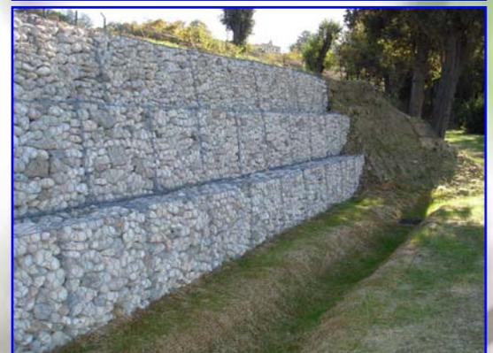
Foto 1 – Stützmauer und hydraulischer Schutz aus Gabionen
